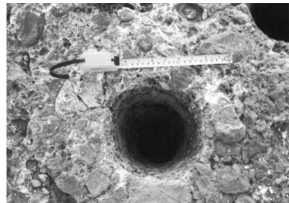
Figura 15 – Acercamiento a mortero perforado en su base de GC Mortero 3 (foto de la autora).
