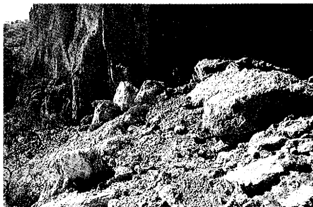
Figura 11 - Derrumbe PZ 13, Cueva de la Vega.
